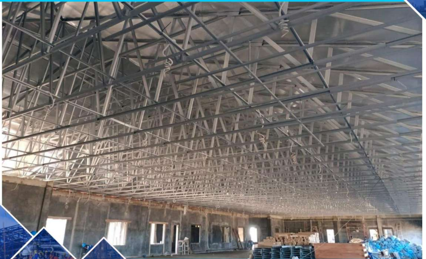
Pemasangan Atap Rangka Baja Ringan PT. Indika Multi Properti (Kaltim)
