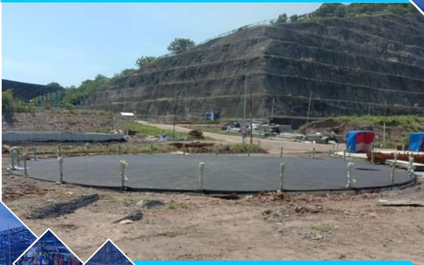
Pekerjaan Pengaspalan Pondasi Tanki PT. Hutama Karya ( Suralaya )
