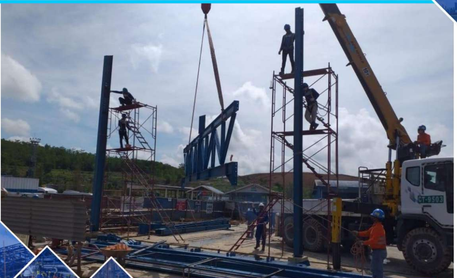
Pemasangan Konstruksi Rangka Baja Berat
