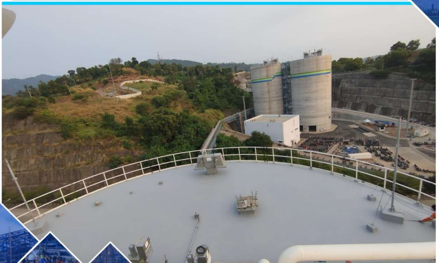
Pekerjaan Epoxy Roof Top Silo, Proyek PLTU 9&10 Suralaya
